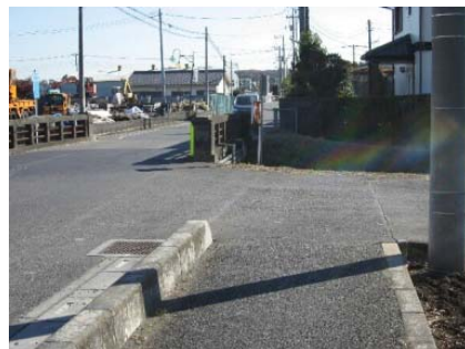
歩道が途切れた宮寺不老川大橋
