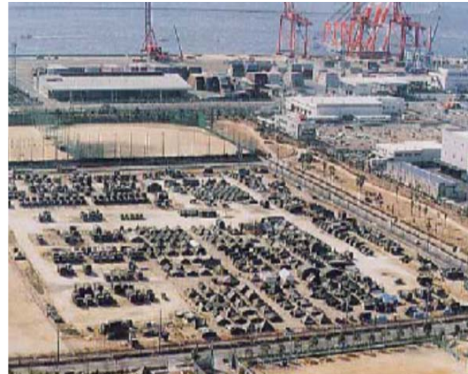
阪神・淡路大震災時の六甲アイランド災害対処拠点施設 (防衛省HPより)
